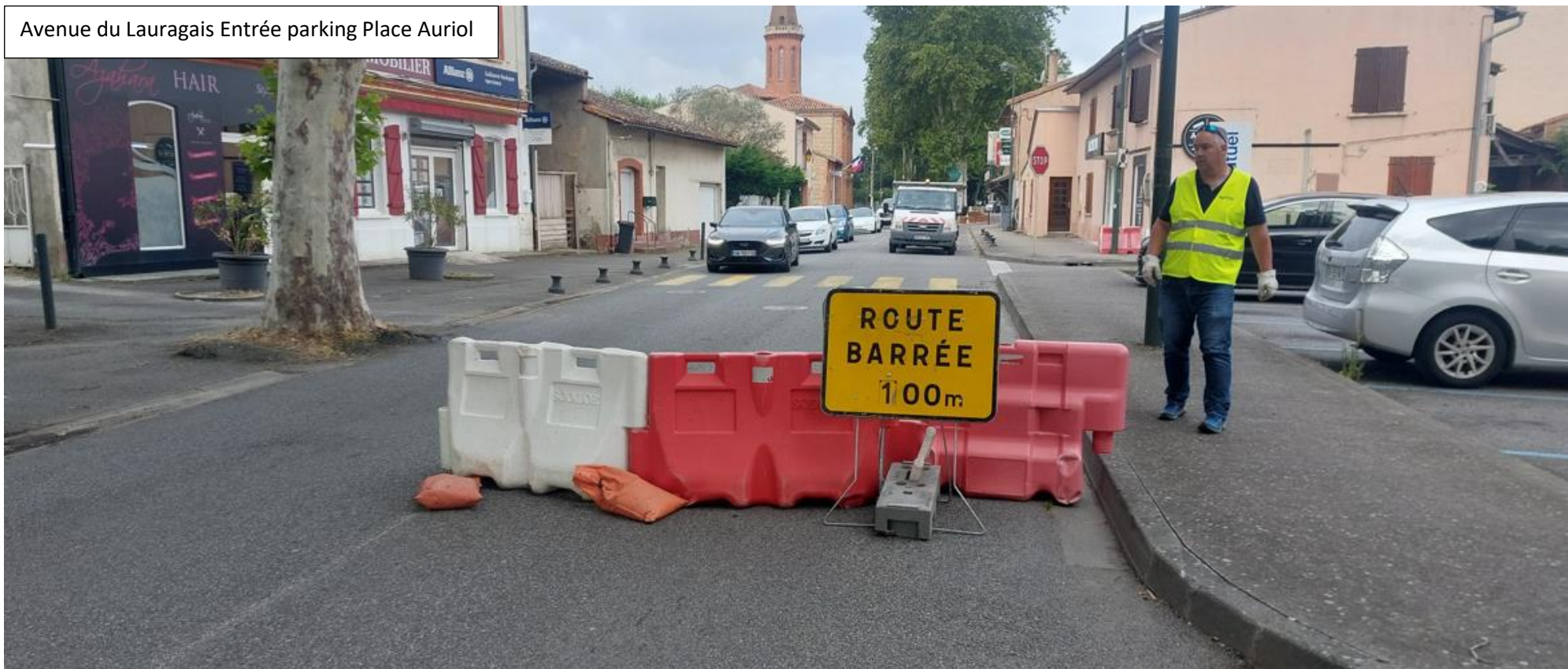
Carrefour à feux : Avenue du Lauragais Caihabat Chemin de Lagardelle
