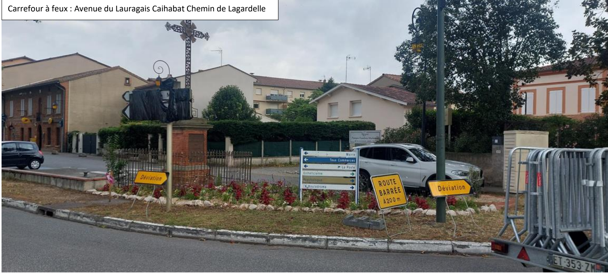
Carrefour à feux : Avenue du Lauragais Caihabat Chemin de Lagardelle
